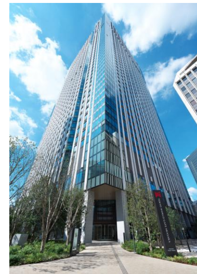
■ 赤坂トラストタワー
