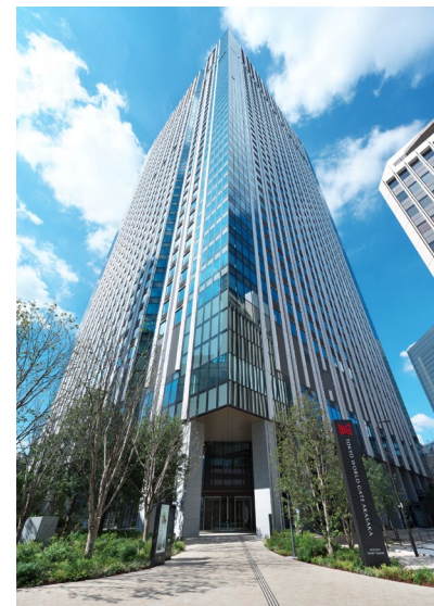
■ 赤坂トラストタワー
