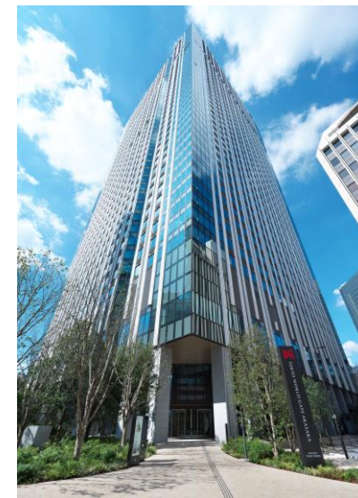
■ 赤坂トラストタワー
